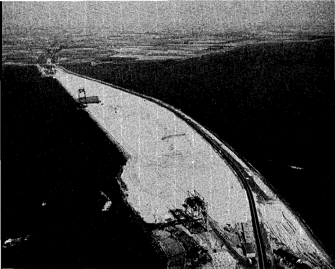
Opbouw van het damlichaam door het noordelijk sluitgat van de Grevelingen
